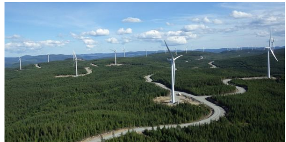
Parc éolien Rivière-du-Moulin
