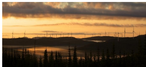
Parc éolien Rivière-du-Moulin
