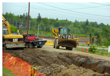
Membertou - Projet d'infrastructure
